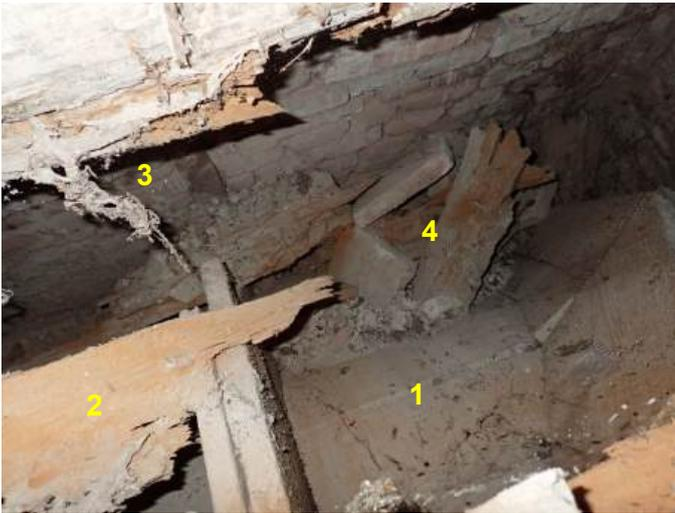
Blick in das NO-Eck vom Dachboden aus: (1) Schalung aus Fichtenholz über Ecke mit Riss, (2) Dippelbaum vom (3) Hausschwamm zerfressen, (4) abgestürzte Teile des Dippelbaums © Florian Tscherne / www.holzforchung.at
