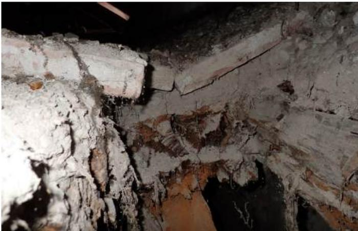
Blick in den Dachboden: (1) Echter Hausschwamm, (2) Querschnitt Dippelbaum, vom Schwamm zerrissen, (3) eingebrochene Ziegel
