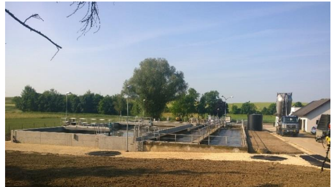
Verbandskläranlage in Velm-Götzendorf
